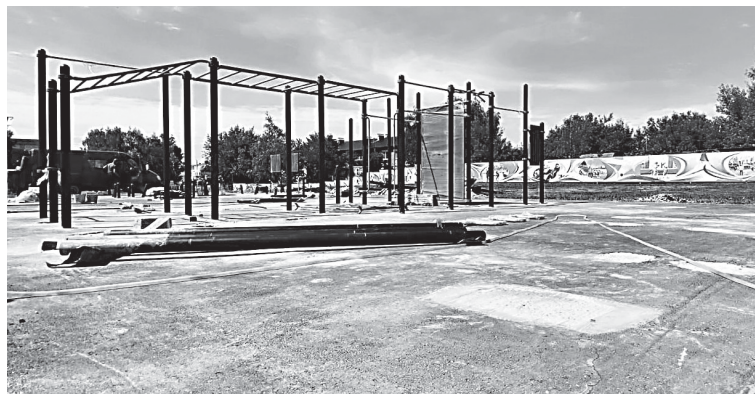
Площадка ГТО на территории Татищевского лицея.
