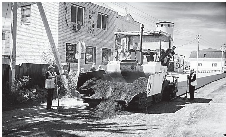
На ул. Чапаева ведутся дорожные работы.
