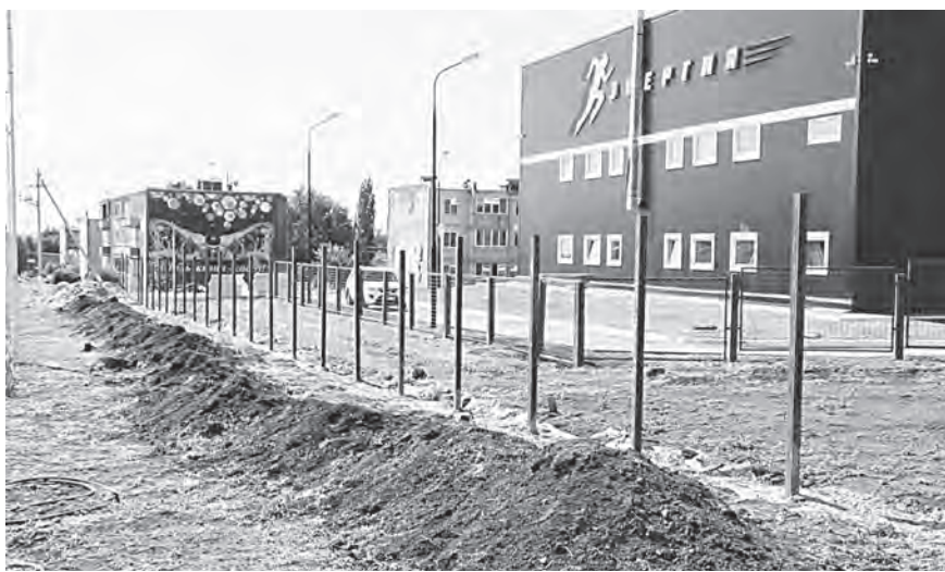
Начались работы по возведению нового забора ФОКа.
