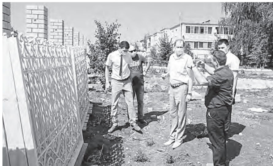
Секции лицейского забора готовы к монтажу.
