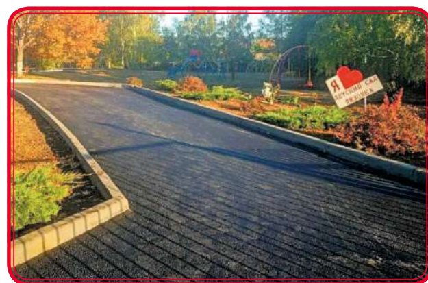
В детском саду села Вязовка завершены работы в рамках депутатского проекта «Ремонт дворов школ и детских садов».
